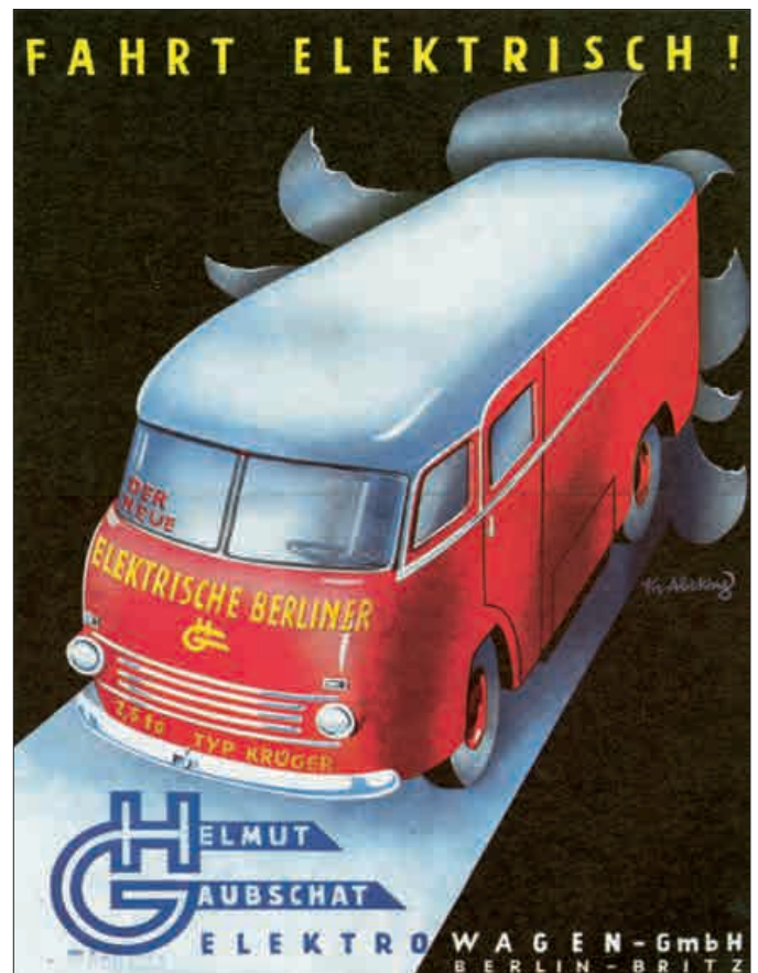
▲ Die Firma Gaubschat fabrizierte in den 1950er Jahren den „Elektrischen Berliner“ mit 2,5 t Nutzlast, Höchstgeschwindigkeit: 27 km/h. © SDTB/Foto: Historisches Archiv
