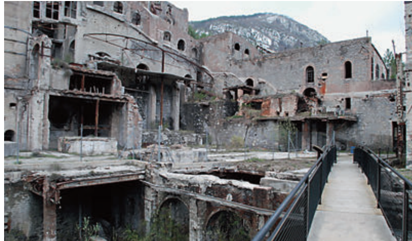
Zementmuseum bei Castellar de n'Hug, Katalonien, Spanien. Gesicherte Rundgänge ermöglichen Besuchern die Erkundung dieser Industriearie.
