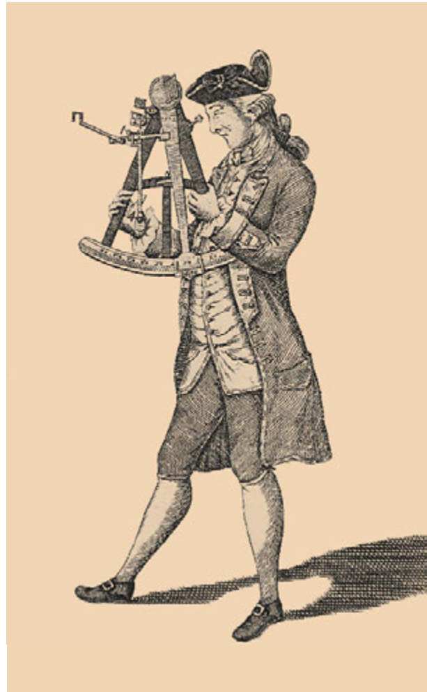
4 Mit dem Oktanten wird der Horizont angepeilt und der Höhenwinkel des Gestirns mittels dessen Spiegelbildes gemessen.
