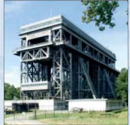
▲ Hebewerk Niederfinow. Foto: Fischer
