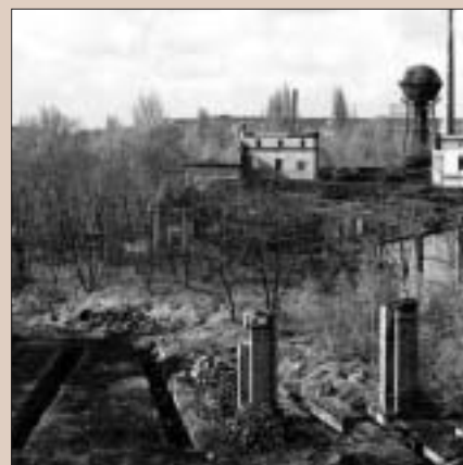
▲ Blick über den ersten Lokschuppen vor den Bauarbeiten, 1984. Foto: Kemner
