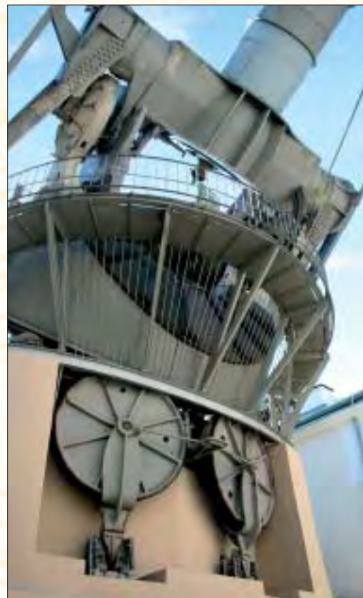
▲ Die großen Rollen des Nordlagers, im Fundamentinnern über Gegengewichte abgefangen. Foto: Rothenberg
