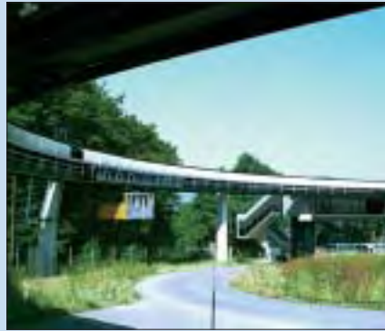
▲ Die C-Bahn auf der Erprobungsanlage in Hagen (1976).
